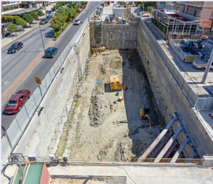
Διάτρηση αγκυρίων - Σταθμός «Γαλάτσι».
