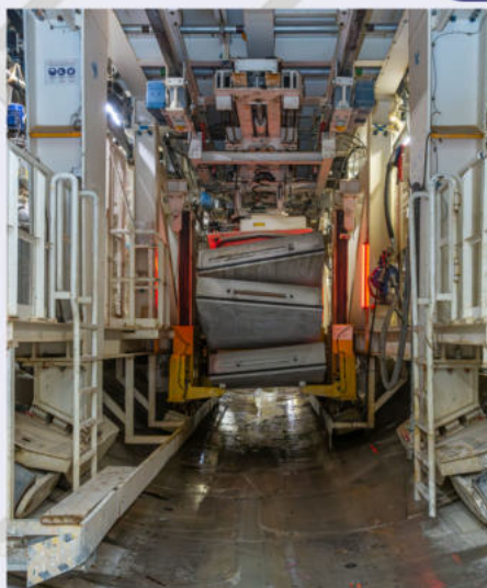
Μεταφορά προκατασκευασμένων δακτυλιδιών TBM «ΝΙΚΗ».
