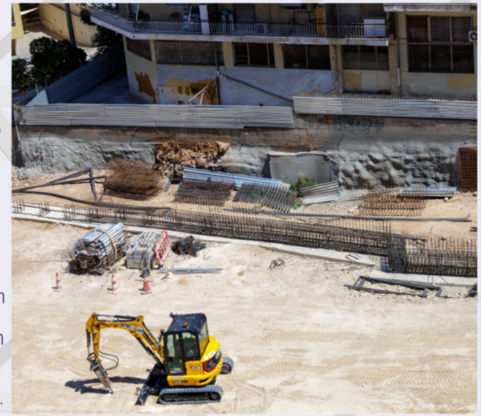
Κατασκευή κεφαλοδεσμου στον Σταθμό «Ελικώνος».
