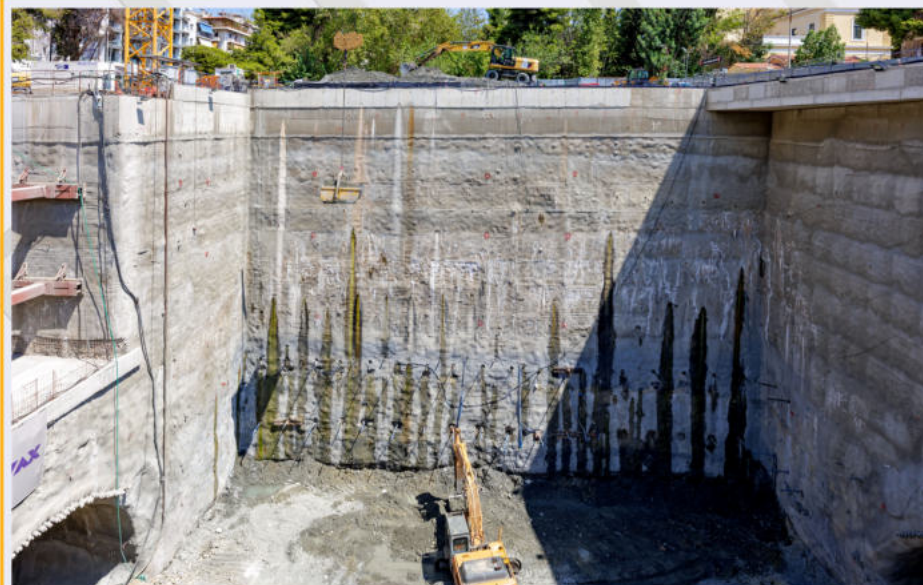
Αποκομιδή προϊόντων εκσκαφής - Σταθμός «Δικαστήρια».
