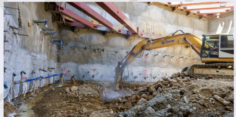
Φρέαρ ΔΙΑΚΛΑΔΩΣΗΣ ΕΥΑΓΓΕΛΙΣΜΟΥ.
