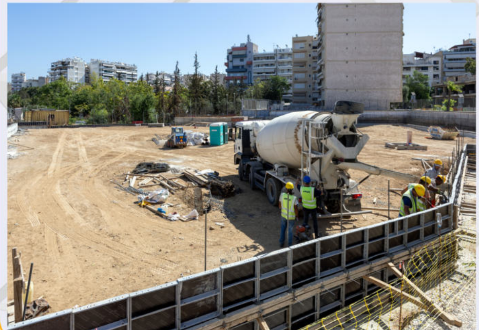
Κέντρο Ελέγχου Λειτουργίας
