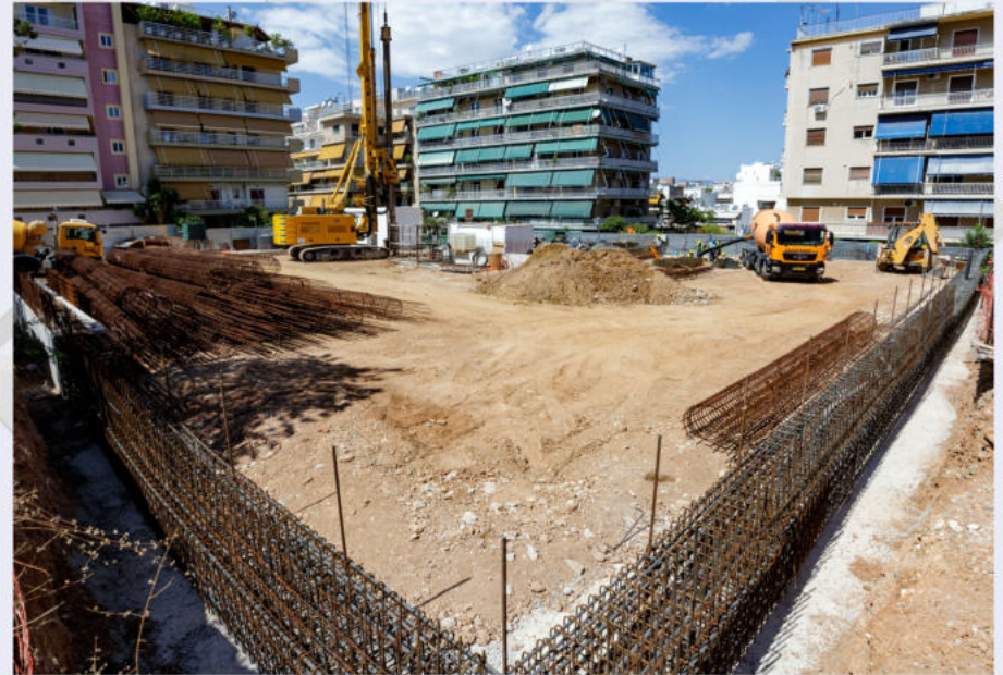
Σκυροδέτηση πασσάλου - Σταθμός «Ιλίσια».
