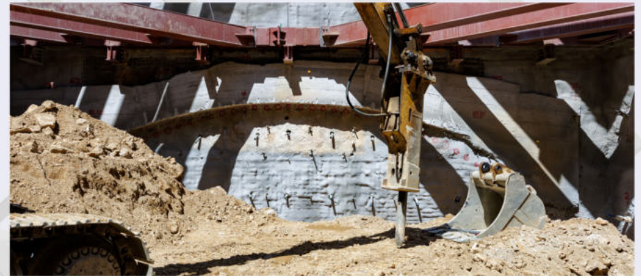
Φρέαρ ΔΙΑΚΛΑΔΩΣΗΣ ΕΥΑΓΓΕΛΙΣΜΟΥ.
