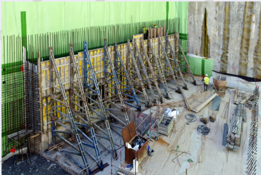
Εργασίες τοποθέτησης μεταλλότυπου των περιμετρικών τοιχίων, Σταθμός «Κολωνάκι».
