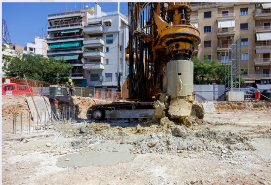
Διάτρηση πασσάλων - Σταθμός «Κυψέλη».
