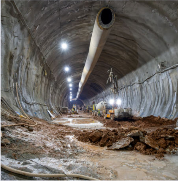
Κατασκευή Γ' φάσης - Φρέαρ ΓΝΑ
