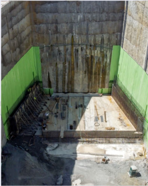
Εργασίες τοποθέτησης μεταλλότυπου των περιμετρικών τοιχίων, Σταθμός «Κολωνάκι».
