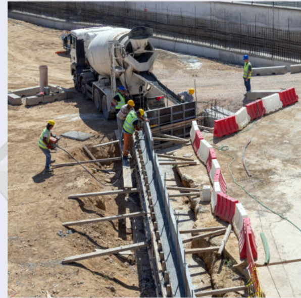
Σκυροδέτηση στηθαίου κεφαλόδεσμου - Κέντρο Ελέγχου Λειτουργίας
