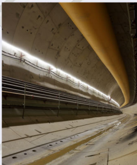
Σήραγγα TBM «ΝΙΚΗ».
