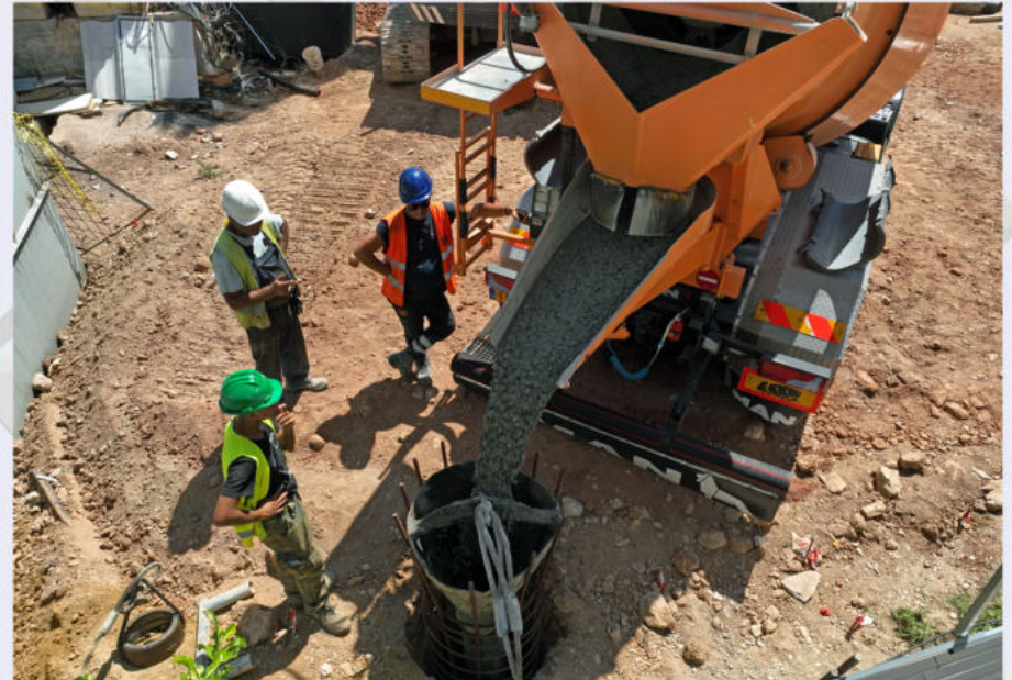
Σκυροδέτηση πασσάλου - Σταθμός «Ιλίσια».
