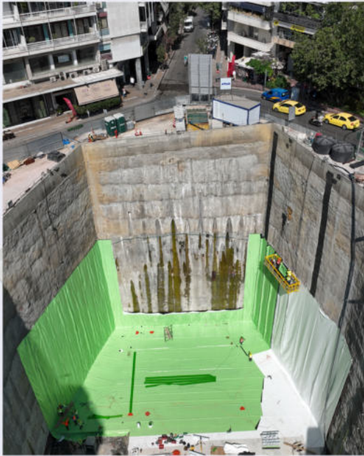
Εργασίες τοποθέτησης συστήματος υδατοστεγάνωσης Σταθμός «Κολωνάκι».
