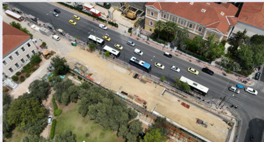
Νότιο φρέαρ - Σταθμός «Ακαδημία».
