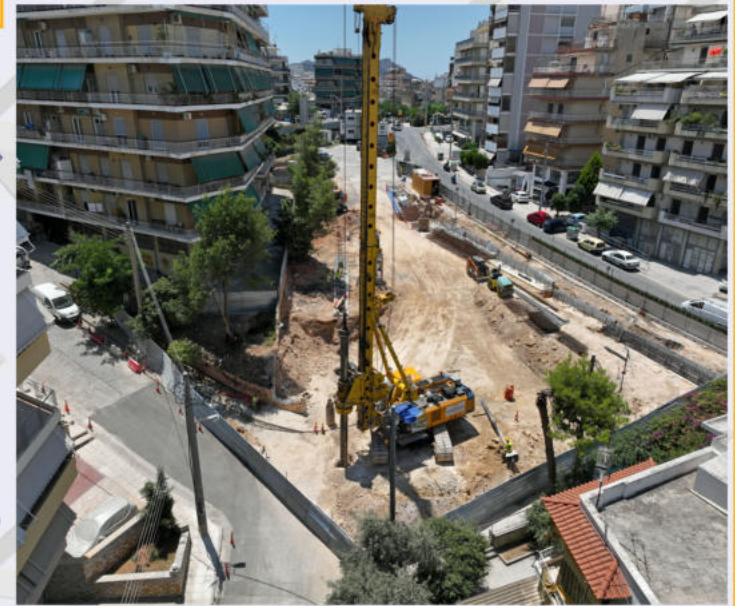
Διάτρηση πασσάλων στον Σταθμό «Ελικώνος»
