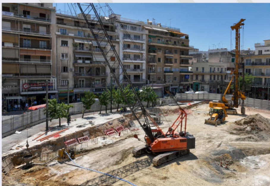
Διάτρηση πασσάλων - Σταθμός «Κυψέλη».
