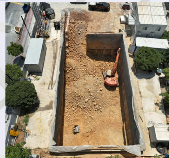
Εκσκαφή στο δυτικό όρυγμα του Σταθμού «Άλσος Βεΐκου».
