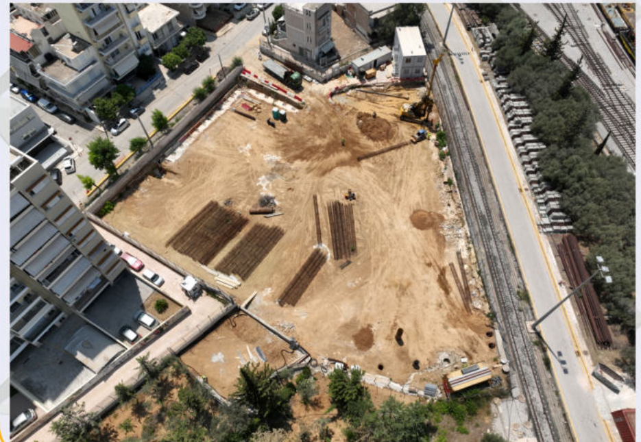
Κέντρο Ελέγχου Λειτουργίας
