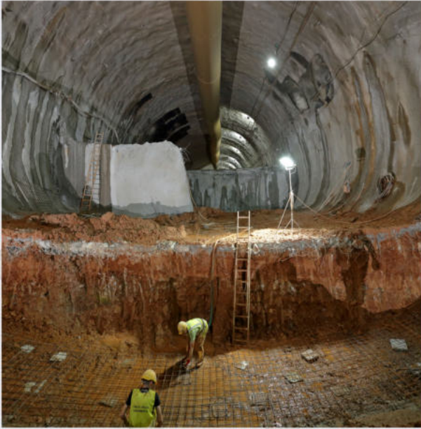
Κατασκευή Γ' φάσης - Φρέαρ ΓΝΑ
