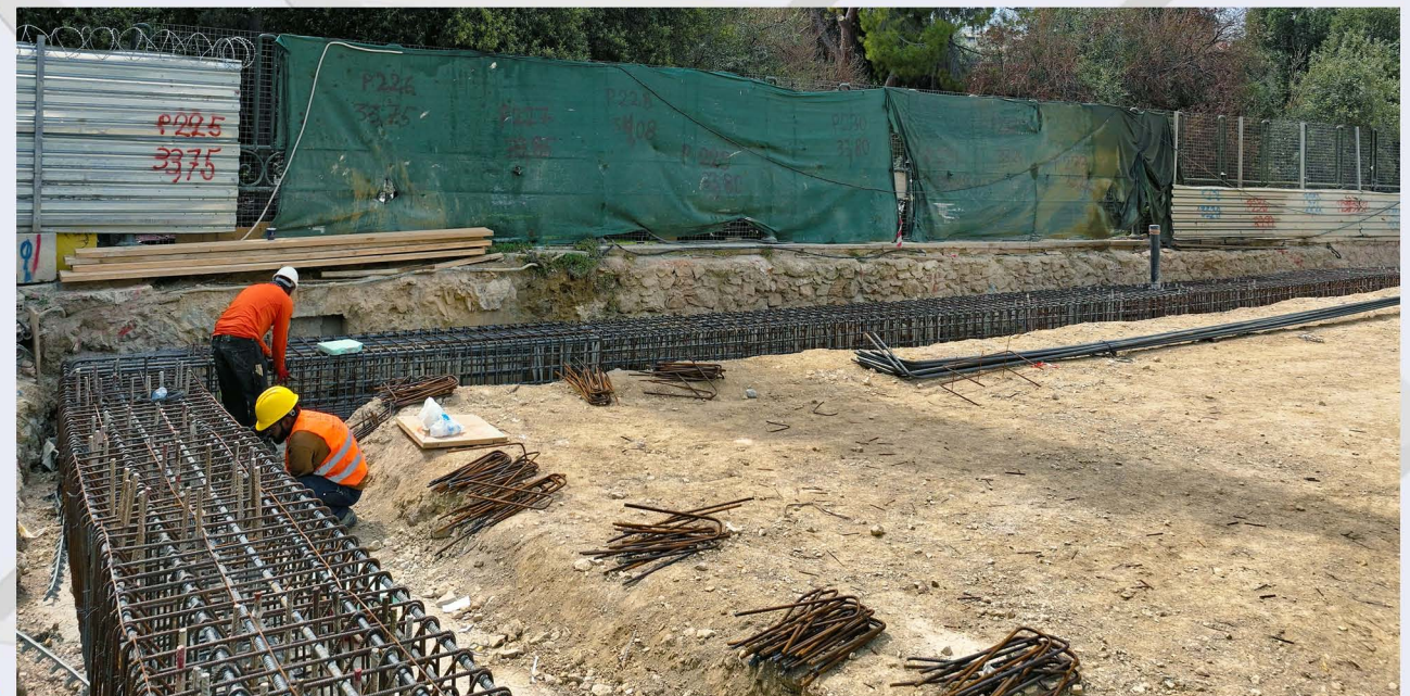
Διαδικασία κατασκευής κεφαλοδέσμου στο Νότιο φρέαρ - Σταθμός «Ακαδημία».
