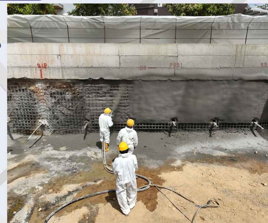
Ριπή εκτοξευόμενου σκυροδέματος στο δυτικό όρυγμα του Σταθμού «Άλσος Βεΐκου».
