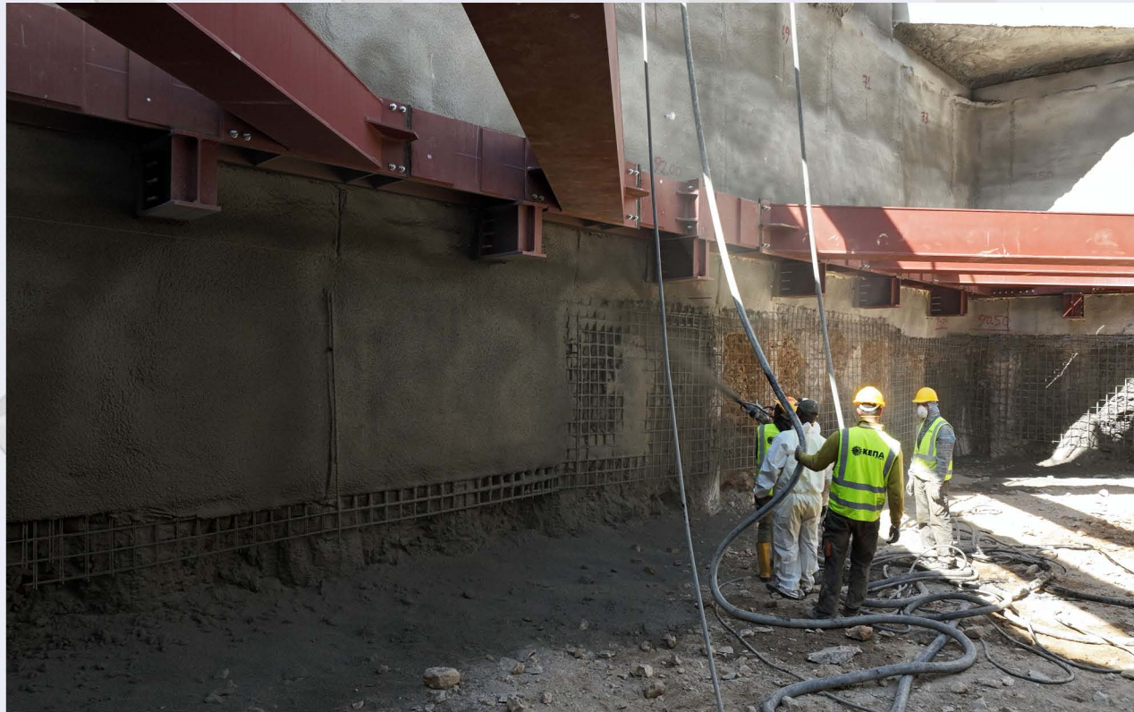
Εφαρμογή εκτοξευόμενου σκυροδέματος - Φρέαρ ΔΙΑΚΛΑΔΩΣΗΣ ΕΥΑΓΓΕΛΙΣΜΟΥ.
