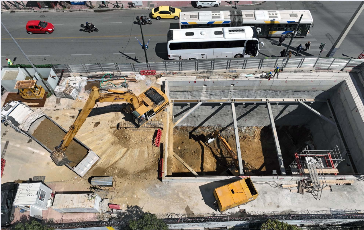
Αποκομιδή και απομάκρυνση προϊόντων εκσκαφής - Φρέαρ ΒΙΒΛΙΟΘΗΚΗ.
