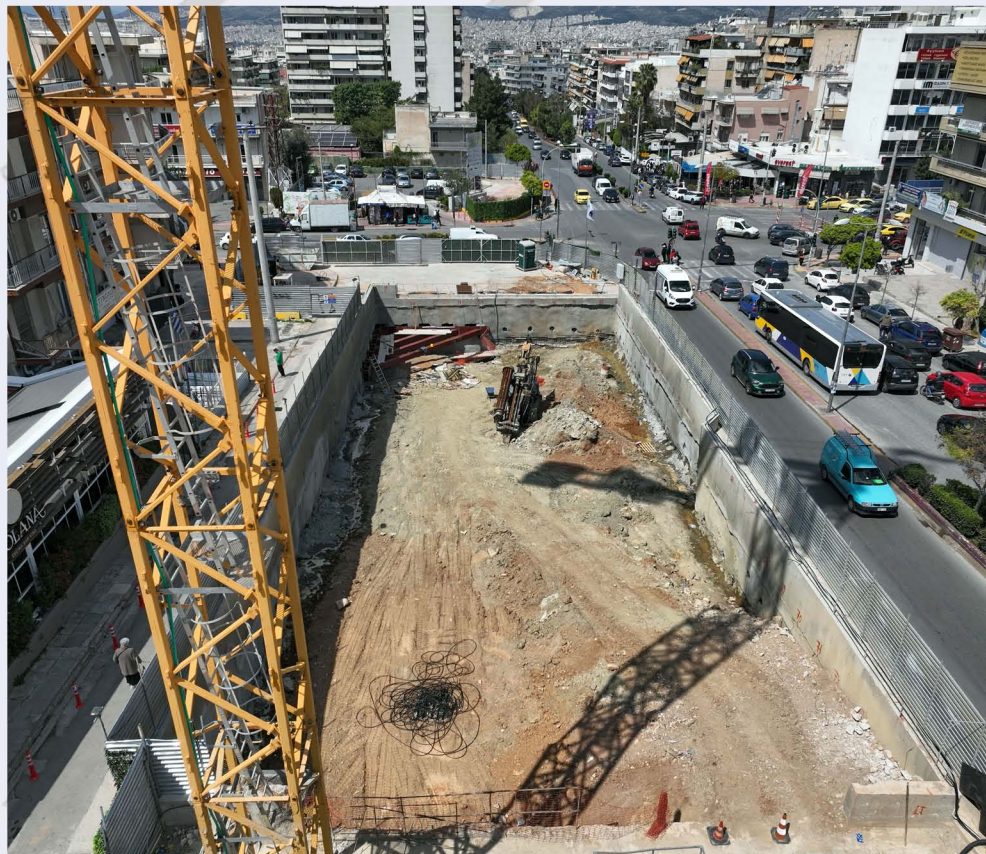
Τοποθέτηση μεταλλικών αντηρίδων - Σταθμός «Γαλάτσι».
