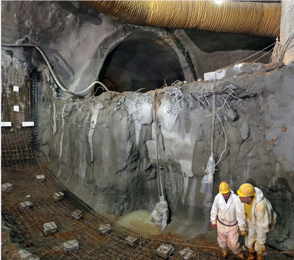
Κατασκευή ανάστροφου τόξου της Β' φάσης της συνδετήριας σήραγγας - Φρέαρ ΓΝΑ.
