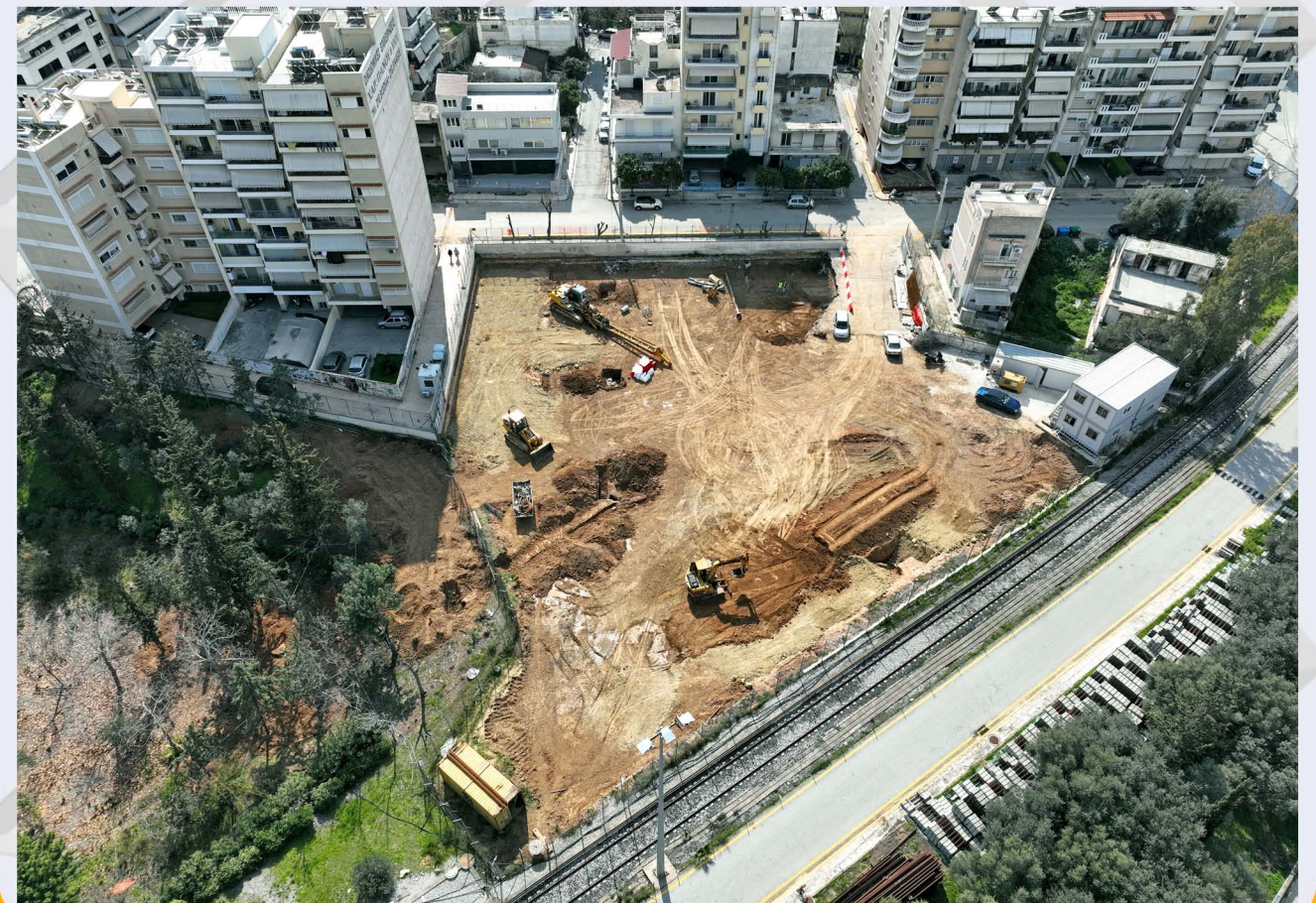
Κέντρο Ελέγχου Λειτουργίας.
