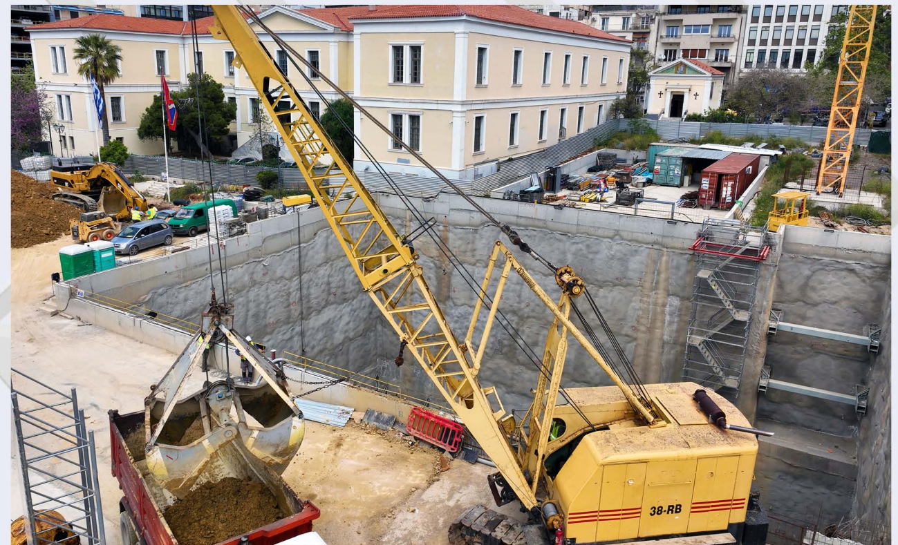
Αποκομιδή και απομάκρυνση προϊόντων εκσκαφής - Σταθμός «Ακαδημία».
