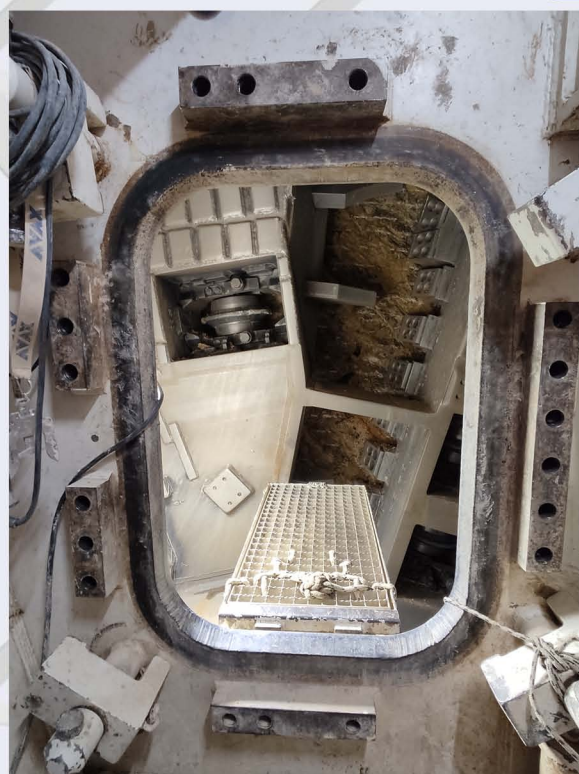
Είσοδος θαλάμου εκσκαφής του TBM.
