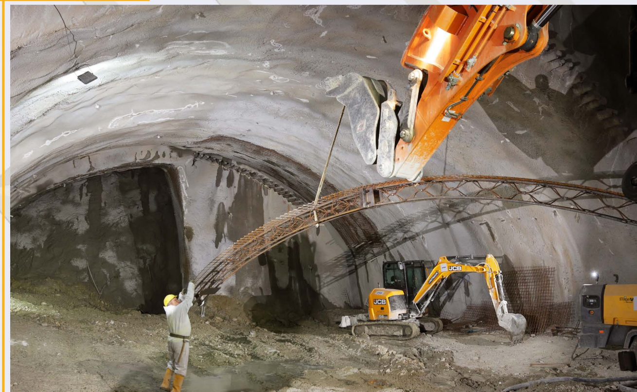
Μεταφορά μεταλλικού πλαισίου για την άμεση τοποθέτησή του στην Φάση Α' της σήραγγας NATM -
