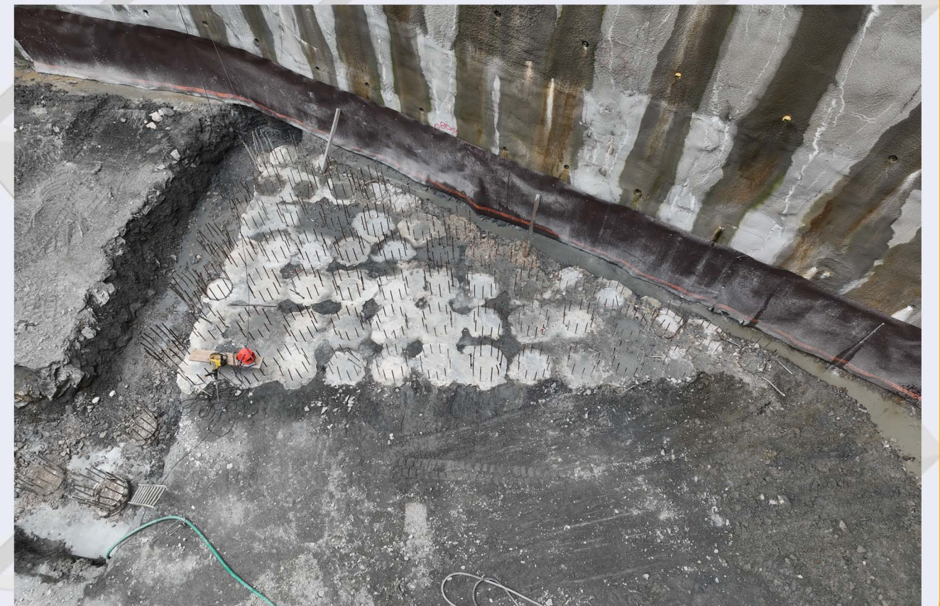
Εργασίες εκσκαφής για την αποκάλυψη αναμονών πασσάλων φρεατίου εκτόνωσης - Σταθμός «Κολωνάκι».
