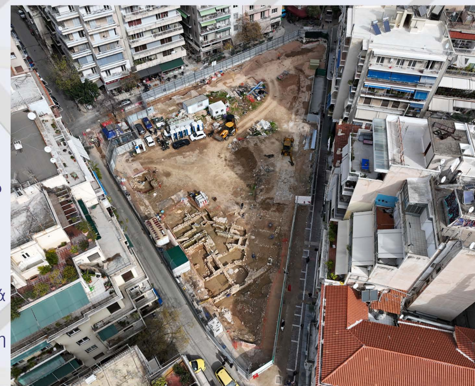
Αρχαιολογικές εργασίες στον Σταθμό «Εξάρχεια».
