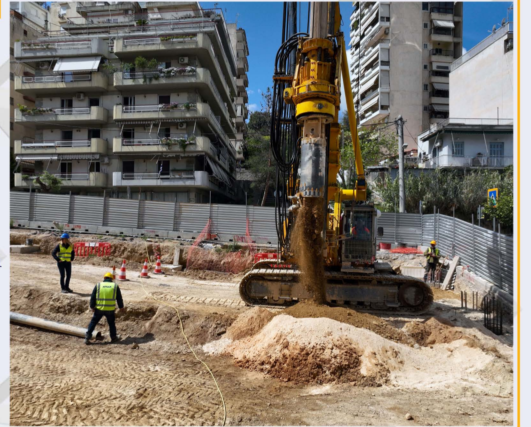
Διάτρηση πασσάλων στον Σταθμό «Ελικώνος».
