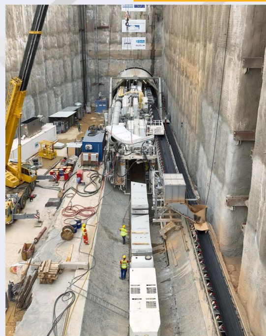
TBM «NIKI» - Veikou TBM Shaft.
