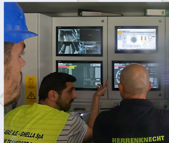
Τμήμα του πιλοτηρίου του TBM.
