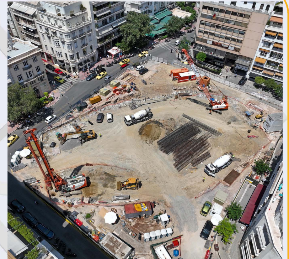
Διάτρηση πασσάλων - Σταθμός «Κολωνάκι».
