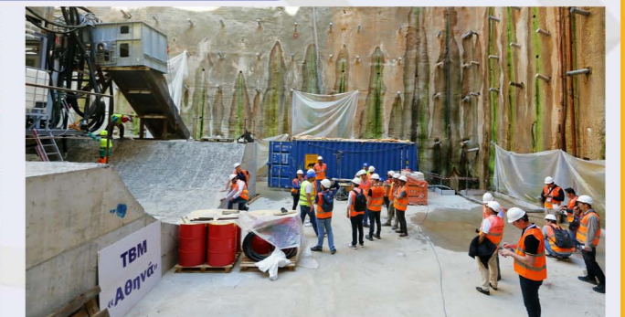
Επίσκεψη του WTC 2023 στο Φρέαρ TBM Κατεχάκη.
