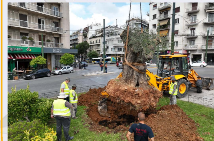
Τοποθέτηση και μεταφύτευση ελιάς στην αρχή της Συγγρού.
