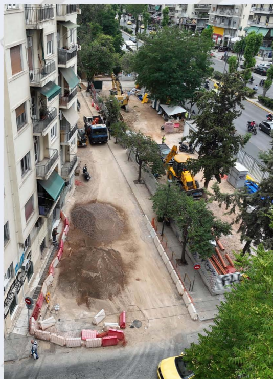
Εργασίες μετατόπισης δικτύων Στ. «Αλεξάνδρας».
