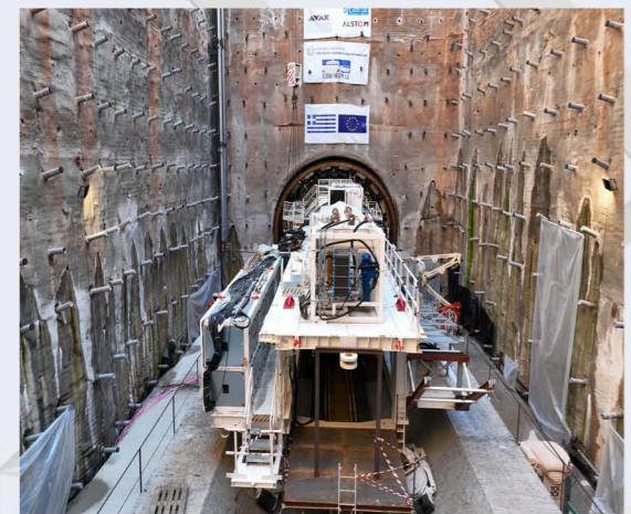
Συναρμολόγηση backup system του TBM.
