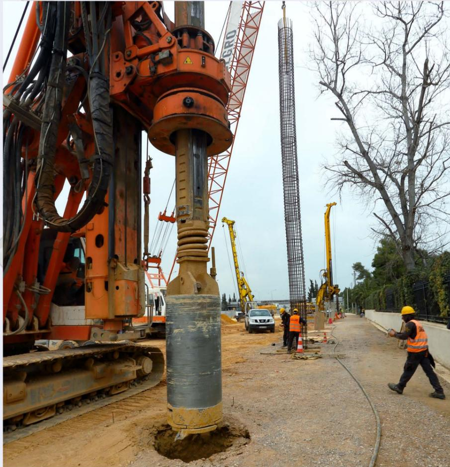
Διάτρηση πασσάλων στο Φρέαρ ΤΒΜ Βεΐκου.
