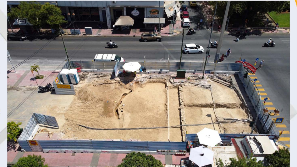
Εργοταξιακή περίφραξη - Φρέαρ «Βιβλιοθήκη».
