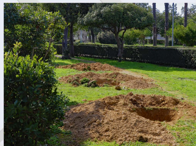
Προετοιμασία εδάφους για την υποδοχή των δέντρων.
