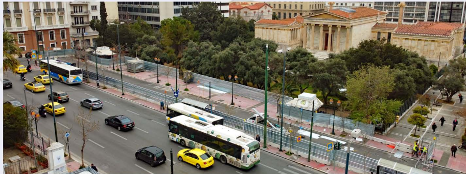
Εργοταξιακές περιφράξεις επί της οδού Κ. Παλαμά (Στ. «Ακαδημία»).
