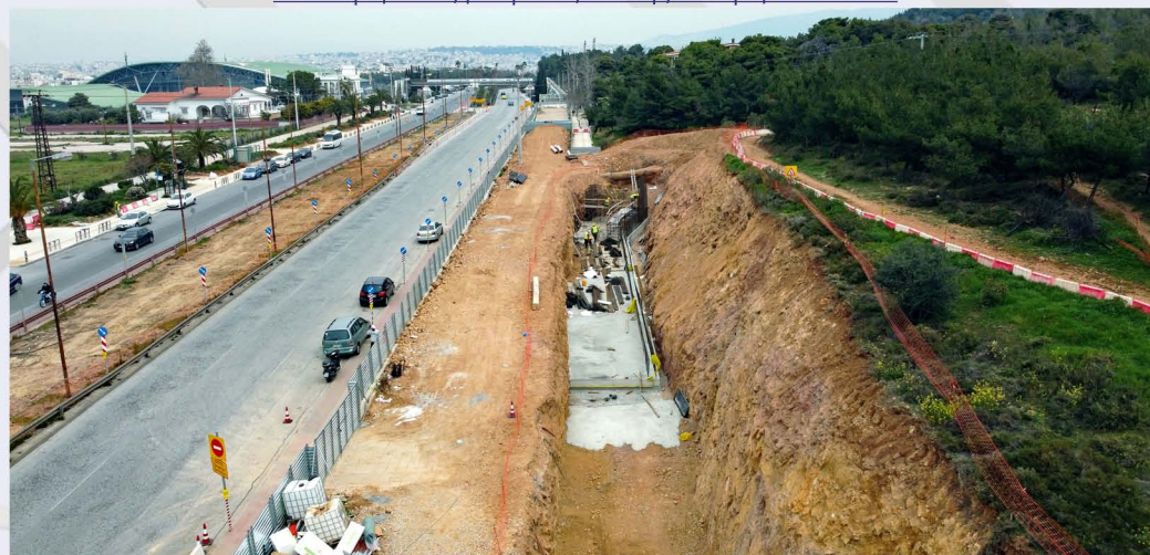
Εκσκαφή για την παράκαμψη των διδύμων αγωγών ύδρευσης Φ900 της ΕΥΔΑΠ.
