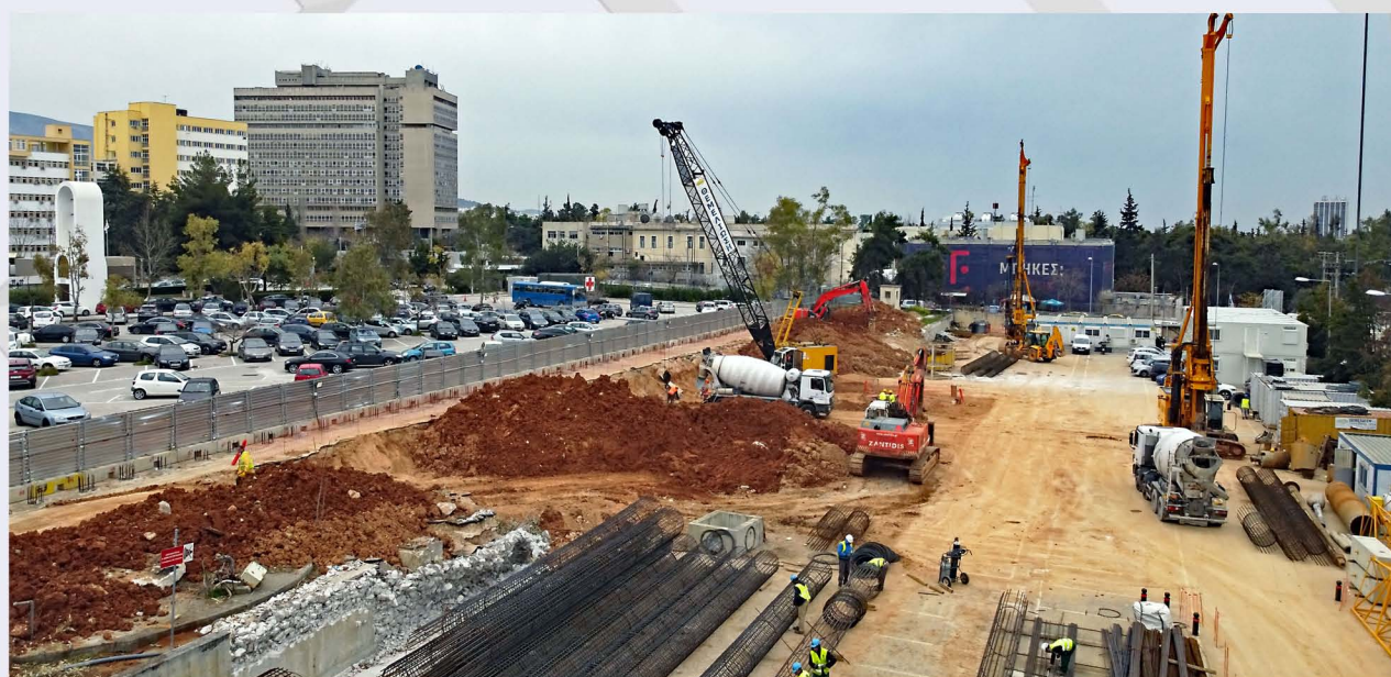
Φρέαρ TBM Κατεχάκη.
